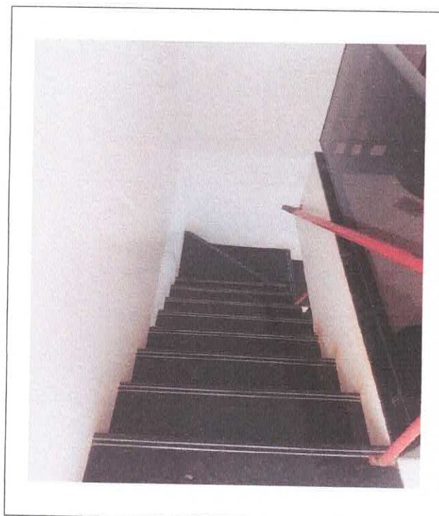
FOTO DA ESCADA DE ACESSO AO ANDAR SUPERIOR
