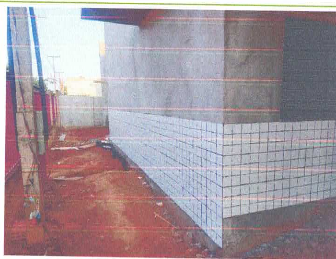
Figura 04 : Frente e Muro a Demolir
