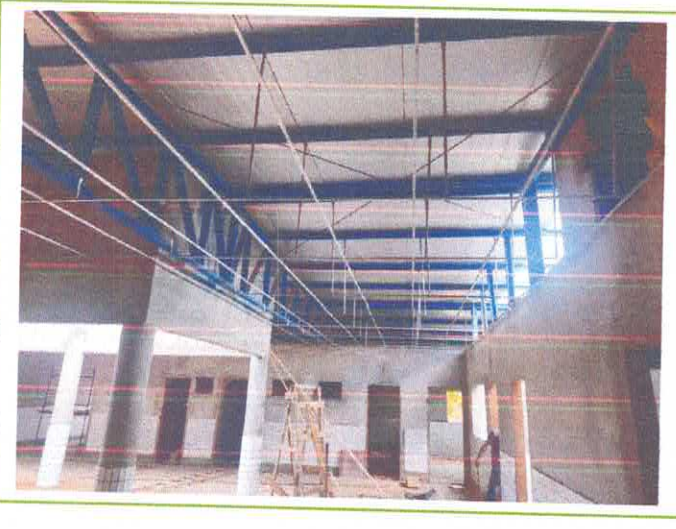
Figura 09 : Vista Interna – Portas Madeira
