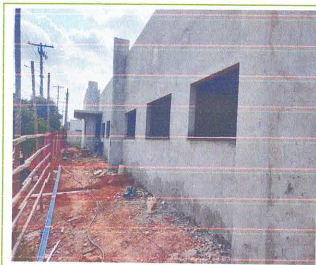
Figura 01 : Frente e Muro a Demolir
