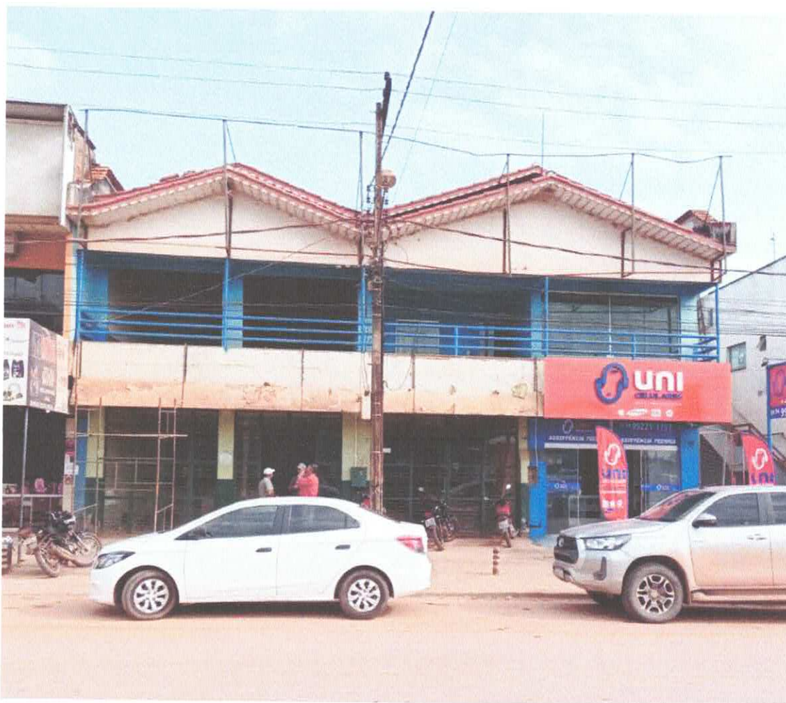
Figura 1: Fachada Principal da Edificação
