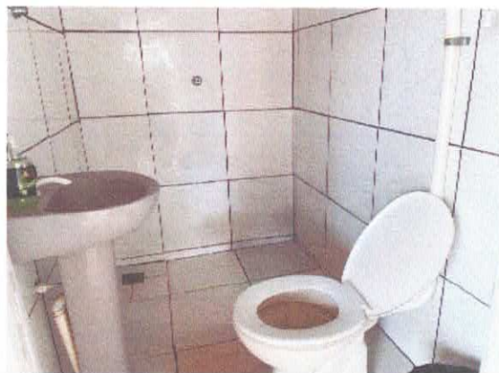
Foto 16 – Banheiro dos funcionários
