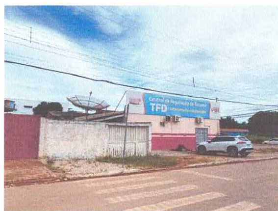
Foto 20 – Fachada lateral esquerda (Rua Piquiá)
