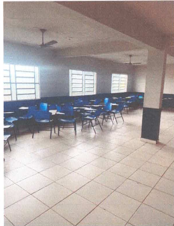
FOTO 10: ÁREA PARA DUAS SALAS DE AULA.
