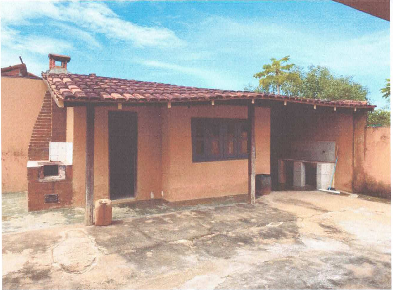
FOTO 04: FACHADA ÁREA DE SERVIÇO
