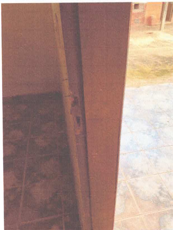
FOTO 13: DETALHE DA FECHADURA DA SALA 02.
