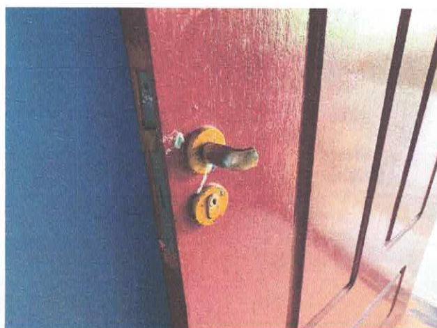
FOTO 19: MAÇANETA DANIFICADA
