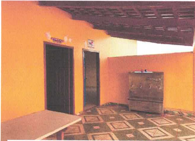
FOTO 20: ÁREA COM ENTRADA PARA DUAS SALAS COM BEBEDOURO
