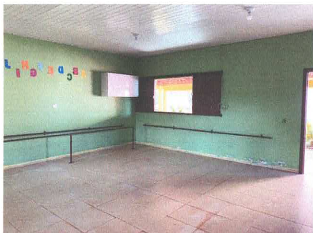
FOTO 16: SALA DE AULA
