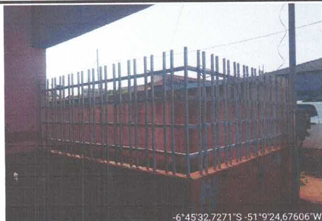
FOTO 03 FECAMENTO DE GRADES
