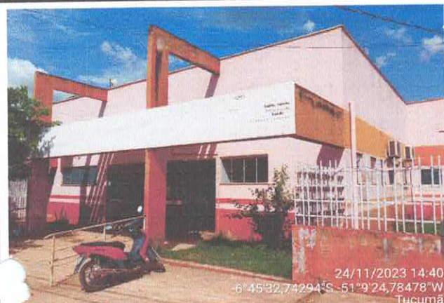
FOTO 01 VISTA GERAL - FRENTE
