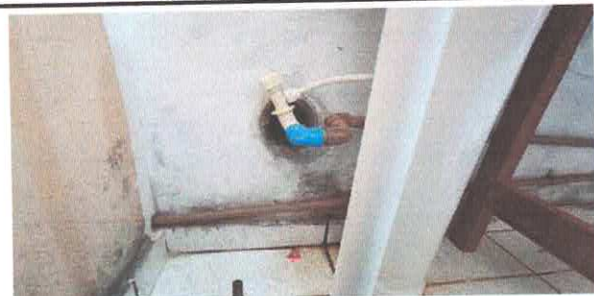
FOTO 09 TUBULAÇÃO DE ÁGUA FRIA EXPOSTA
