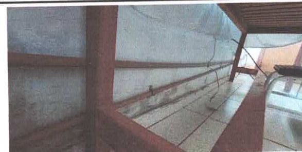
FOTO 10 TUBULAÇÃO HIDRÁULICA EXPOSTA
